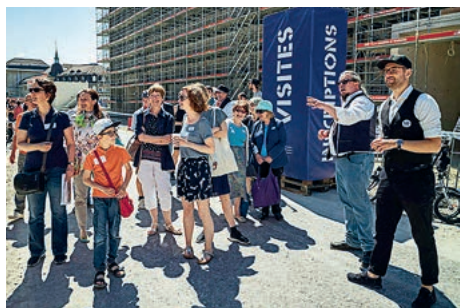
Visite publique du chantier, 2 juin 2018
